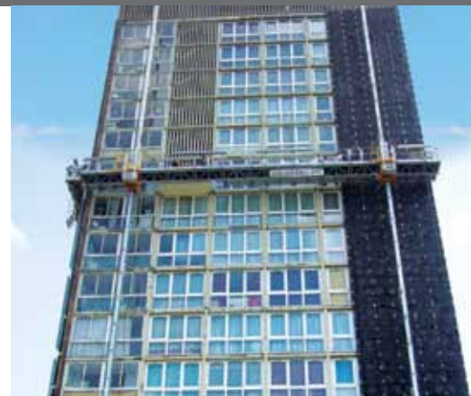
Pose de l'isolation
