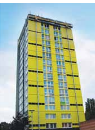
La Tour du Tilleul rénovée
