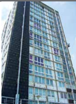
Pose de l'isolation
